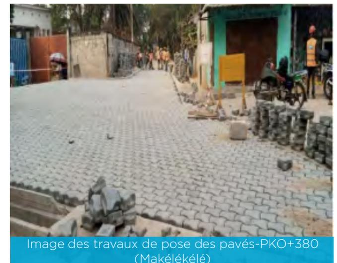
Image des travaux de pose des pavés-PKO+380 (Makélékélé)
